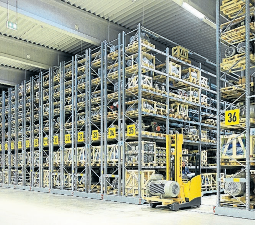
Moderne Lagerlogistik inklusive eines automatischen Verschieberegalsystems optimiert den Handelsbereich.
